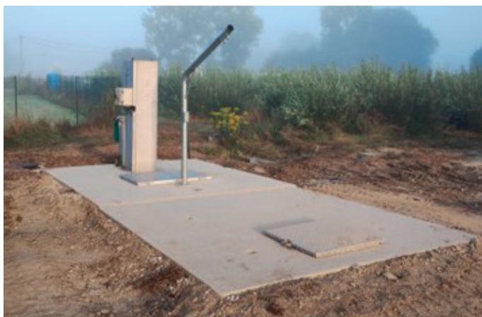
Refonte du poste de relevage
