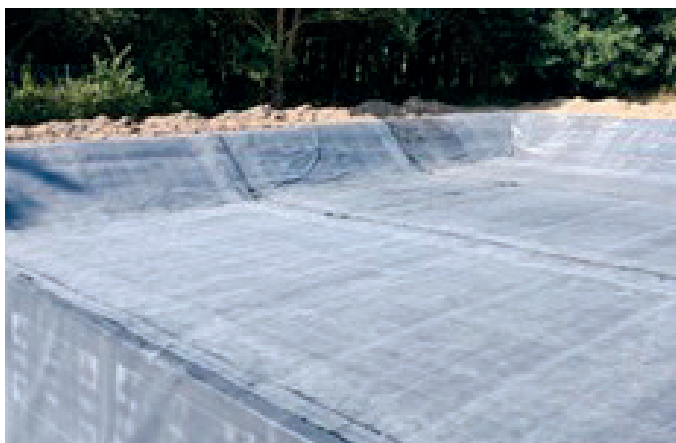
Mise en place Géomembrane
